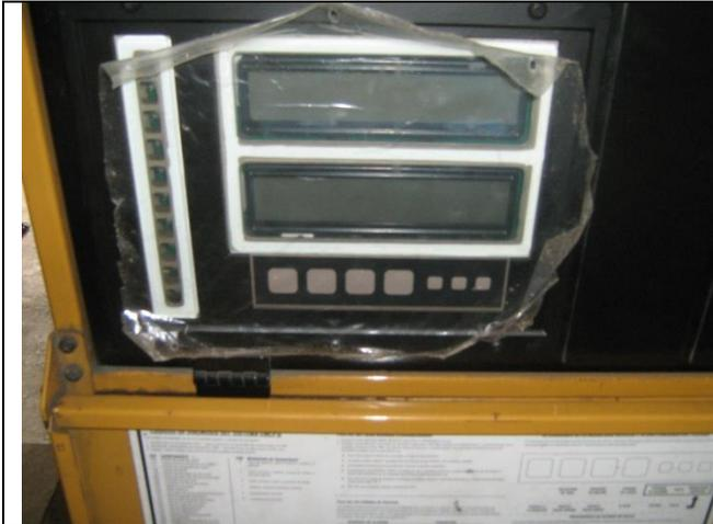
Instalación de controlador EMCP II+ en grupo electrógeno 3456
