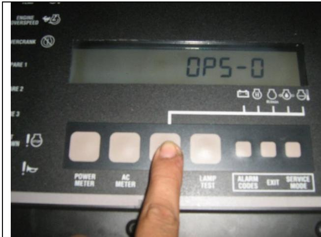
Ingreso a través de la tecla desplazamiento hacia abajo hasta llegar al punto OP5 en EMCP II y OP5-0 en EMCP II+
