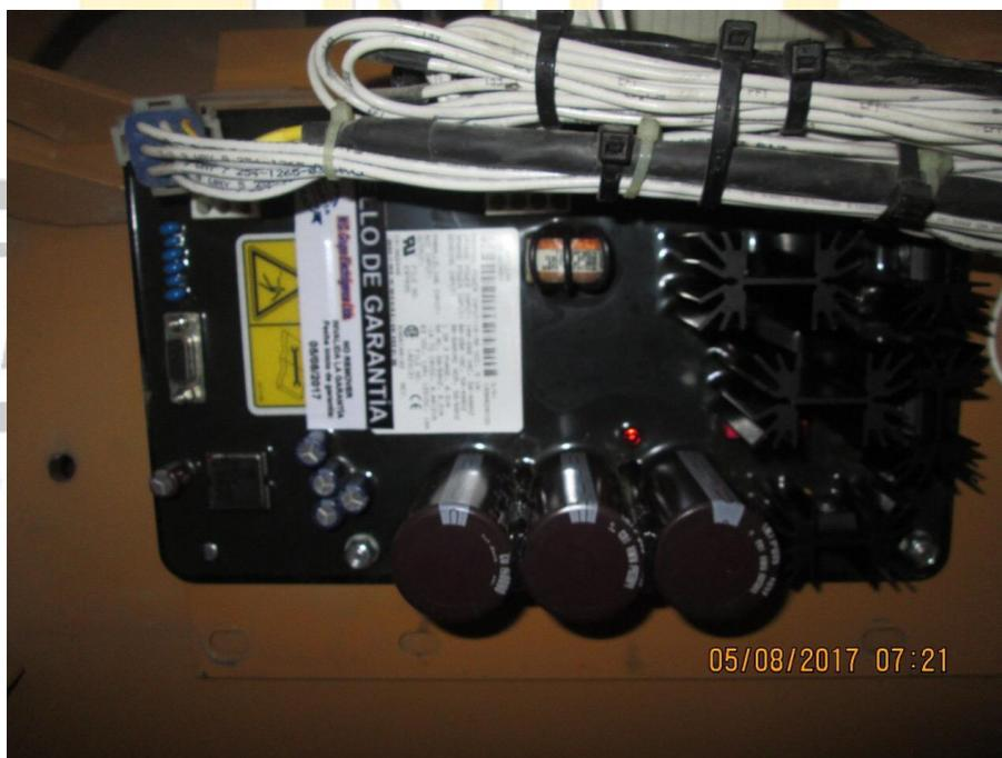
**Reparación de alternadores, configuración de reguladores de tensión CDVR Caterpillar**
