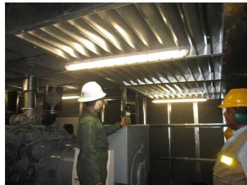
Análisis de flujo de aire en el cuarto del equipo
