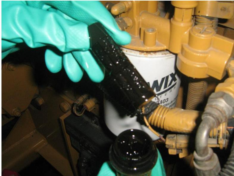
Lodos en filtro de línea de grupo electrógeno Olympian debido a falta de mantenimiento al sistema de almacenamiento de combustible diésel.
